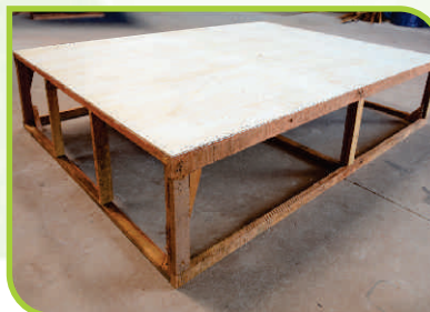
Estrutura de madeira
